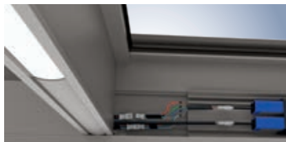
B Verkabelung LED am mittleren Dachträger
